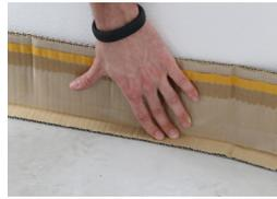
der öko-randdämmstreifen wird bis mindestens unterkante. trittschalldämmung verlegt, die selbstklebende folienlasche wird mit der pe-folie verklebt. (saubere eckbildung beachten)
