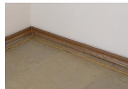
verlegung von wärme- und trittschalldämmungen (z.b. mineralfaser, holzfaser oder polystyrol) erfolgt auf besenreinem untergrund. anschließend erfolgt die abdeckung der dämmung mit der bavaria pe-estrichfolie (0,2 mm). diese muss, je nach estrichart, abgeklebt werden.
