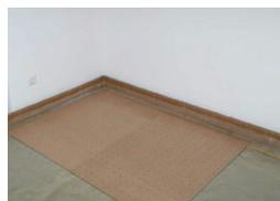
die biofaser-lochplatte mit einem wandabstand von ca. 2 - 5 cm auf die pe-folie (0,2 mm) und unterdämmung verlegen. (glatte seite nach oben)
