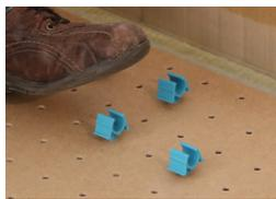
die drehclips werden per hand in die löcher der biofaser-lochplatte vorgesteckt. nach sichtkontrolle der vorgesteckten fläche können diese nun endgültig fixiert werden.
