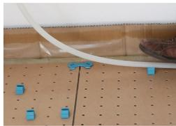
das heizrohr vom verteilbar beginnend, in die vormontierten drehclipse einbringen. die nutzung einer abwickelvorrichtung erleichtert die verlegung des heizrohres.
