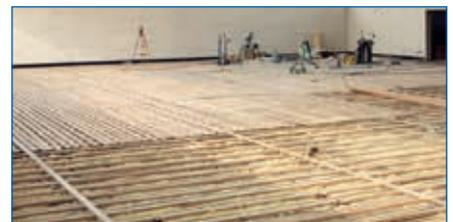
schwingbodenkonstruktion mit integriertem bAVDRIA-royal rohr
