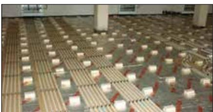
schwingbodenkonstruktion mit integriertem bAVDRIA-royal rohr
