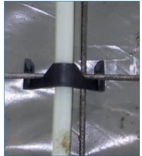
rohrbefestigung mittels bAVRIA-indufixclip auf der untern bewehrung
