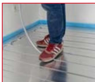
Verlegung der Rohrleitung
