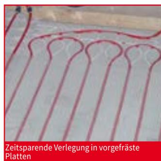
Zeitsparende Verlegung in vorgefräste Platten
