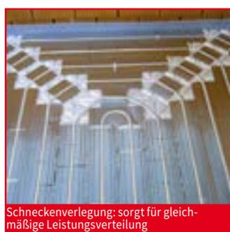
Schneckenverlegung: sorgt für gleichmäßige Leistungsverteilung
