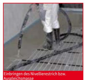
Einbringen des Nivellierestrich bzw. Ausgleichsmasse
