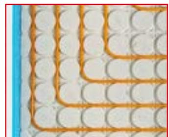
Verlegte Fläche vor dem Einbringen der Füllmasse
