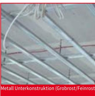
Metall Unterkonstruktion (Grobrost/Feinrost)
