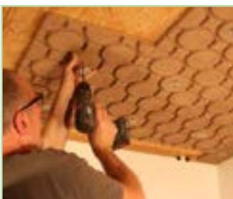
Montage Hochleistungs-Lehmmodul auf Unterkonstruktion
